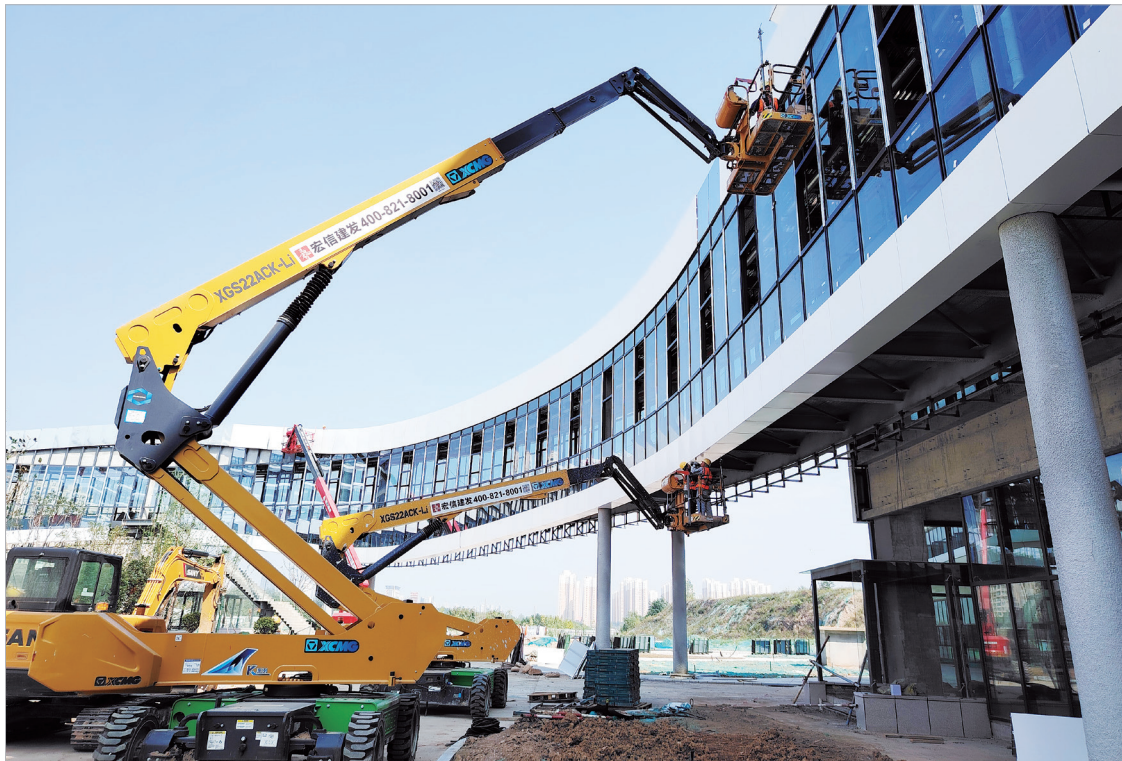
市中心医院港务区院区和市感染性疾病诊疗中心项目施工现场
