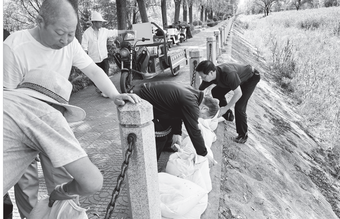
演练用沙袋封堵子堤渗漏
