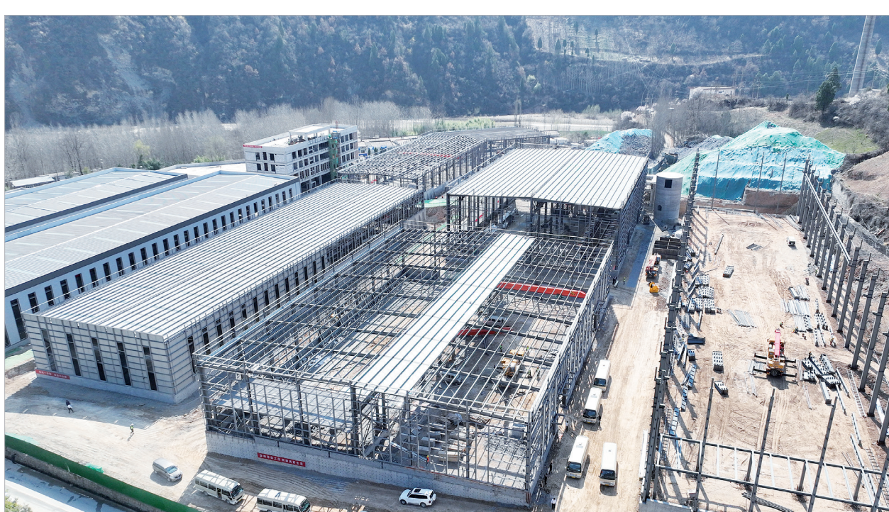
循环经济产业园产业孵化基地项目建设现场 本报记者 谢克强摄
