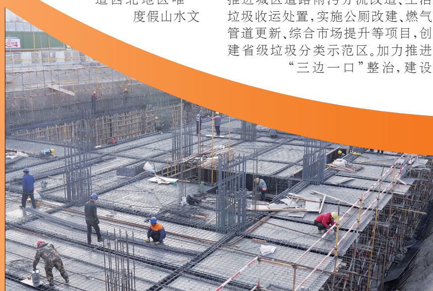
西部智造创新园项目建设现场
