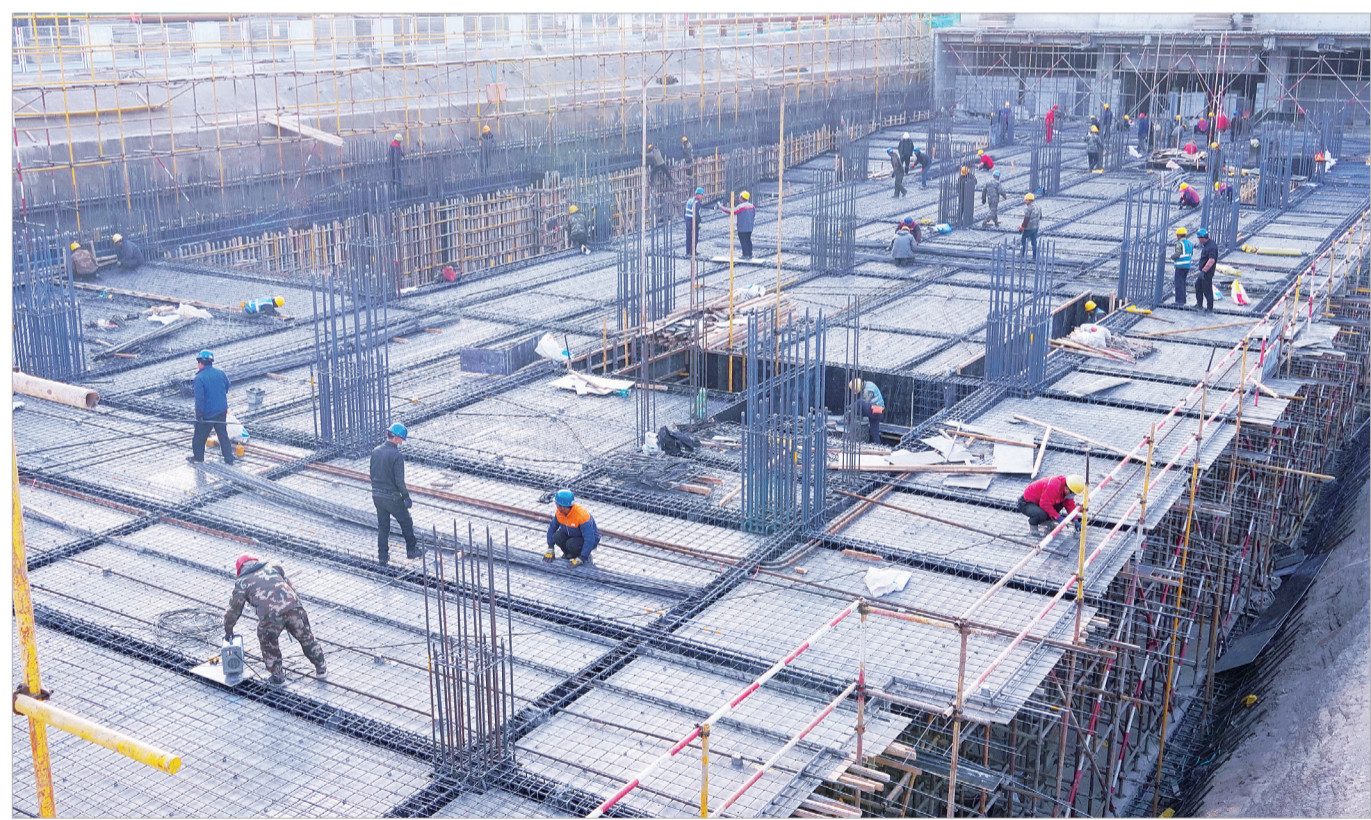
▲姜谭经开区西部智造创新园项目正在如火如荼建设中
