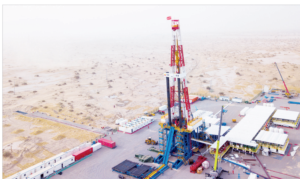
宝石机械生产的首台12000米自动化钻机矗立在深地塔科1井
