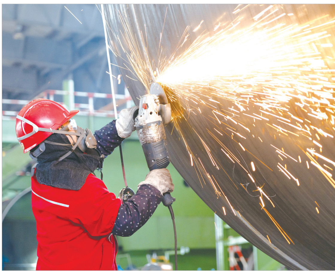
工人在给钢管做表面处理
