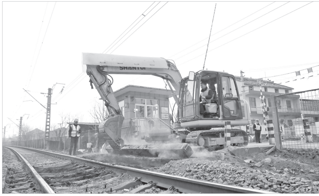
挖掘机在魏家崖铁路道口施工
