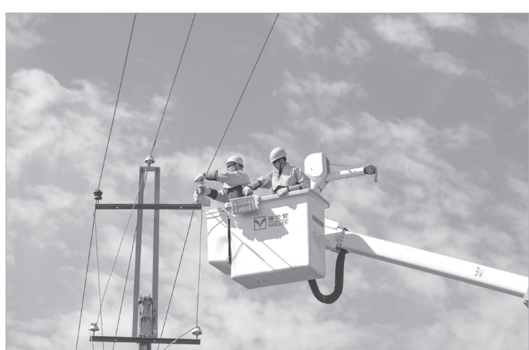
国网宝鸡供电公司员工开展配网带电作业
