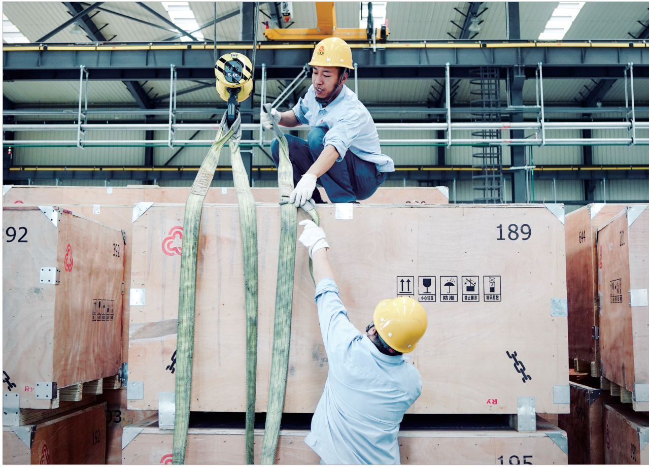
工人在吊装接触网装备
