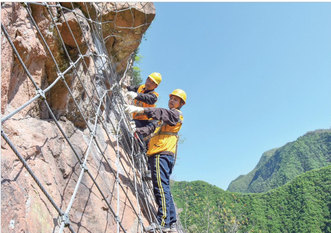
近日，中铁西安局集团有限公司宝鸡工务段职工在陇海铁路老柴窝二号隧道附近进行山体排危作业。
