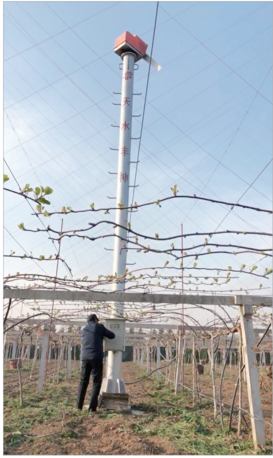
技术人员操作防霜冻风机
