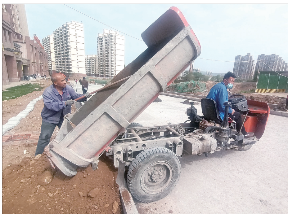
工人正在加紧施工
