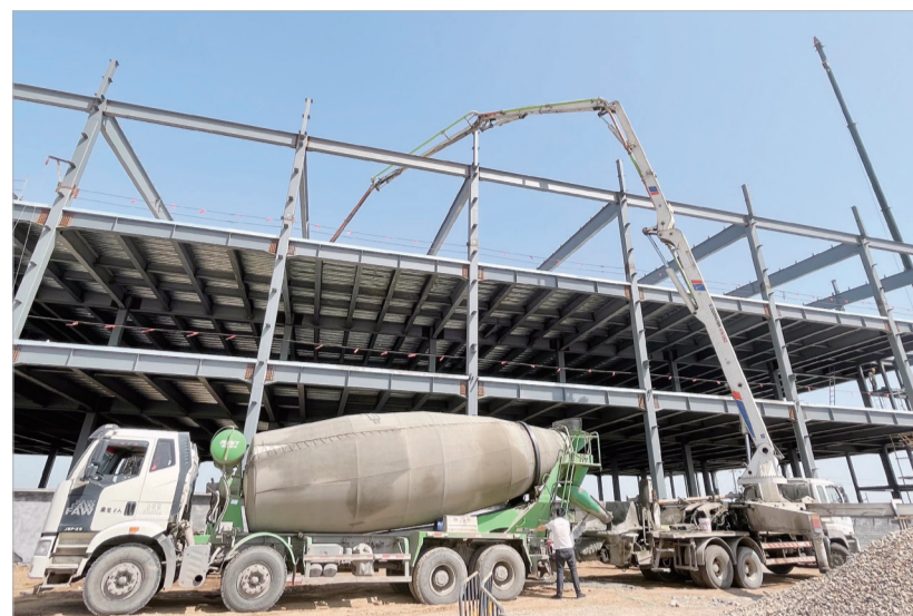
项目施工现场
