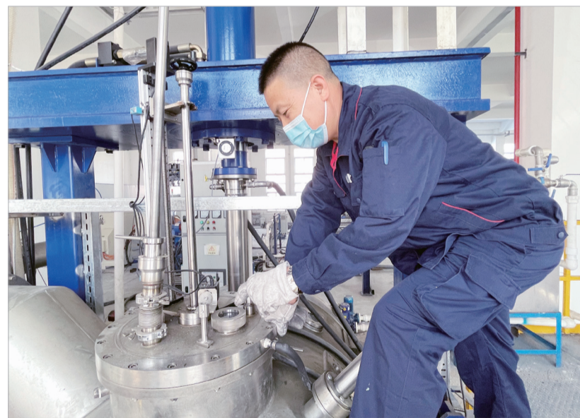
工人在检修设备
