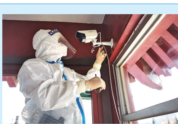
保障人员现场安装视频监控
