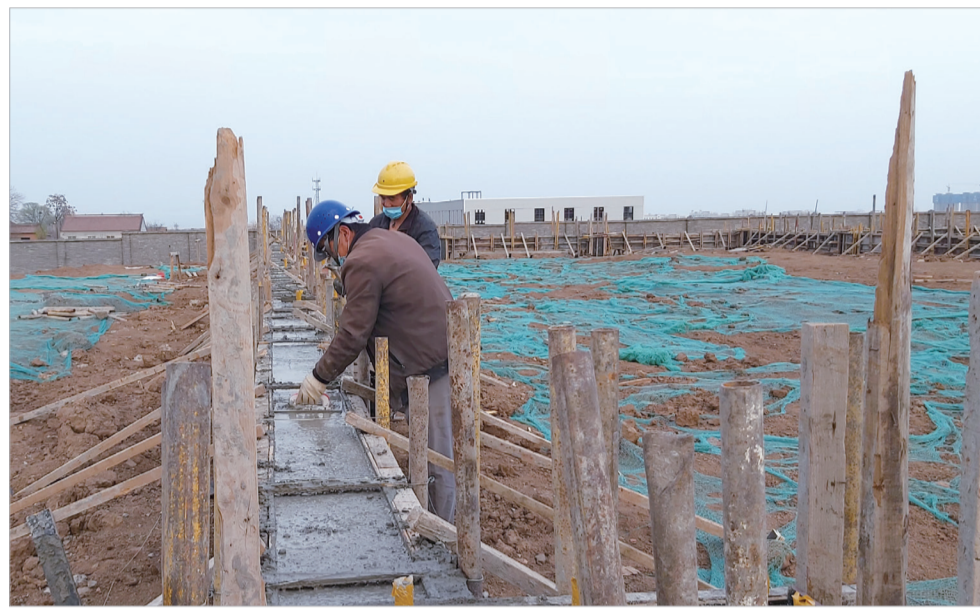
工人加紧建设
