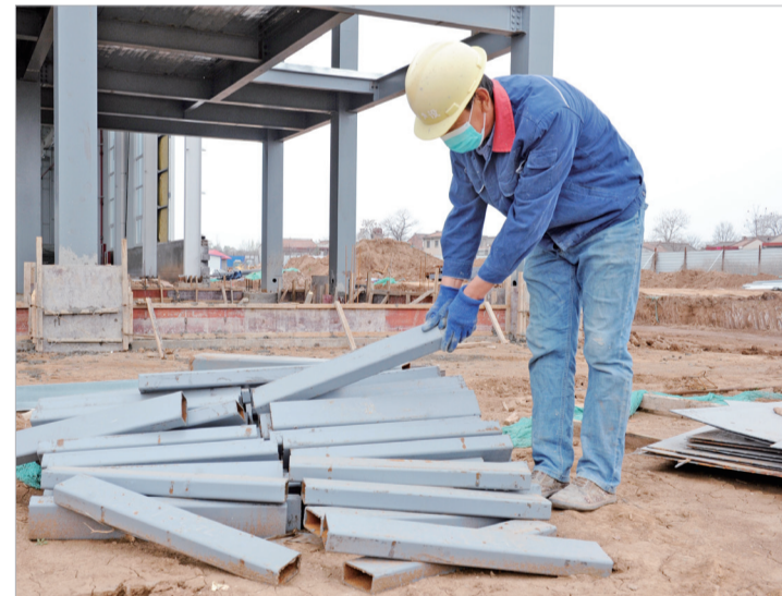
工人将需要焊接的方管搬到车间里
