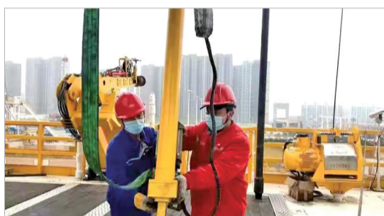
工人在检修设备
