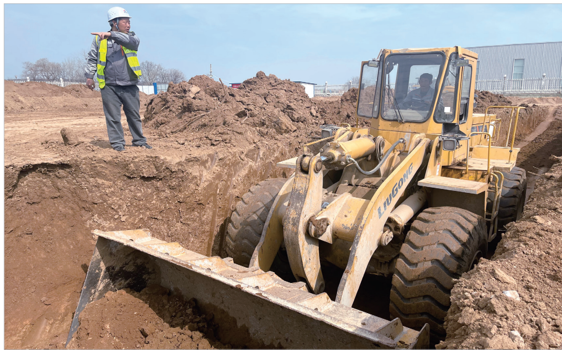
推土机开挖基坑
