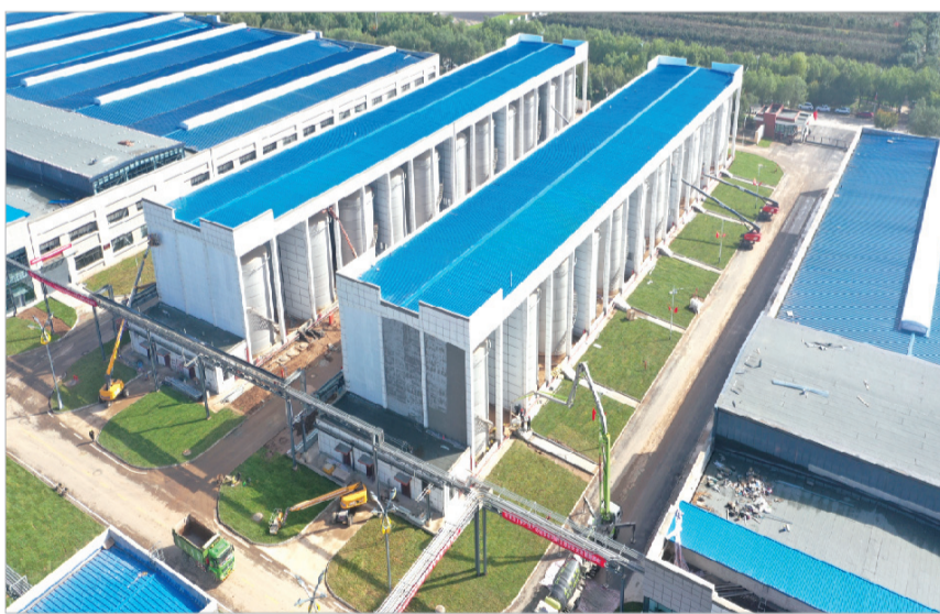
西凤酒扩建技改项目建设场景
