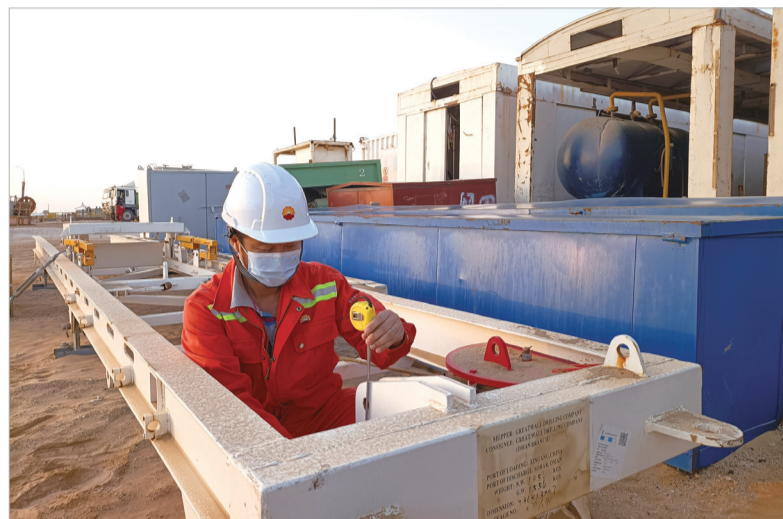
乔磊在海外工地施工
