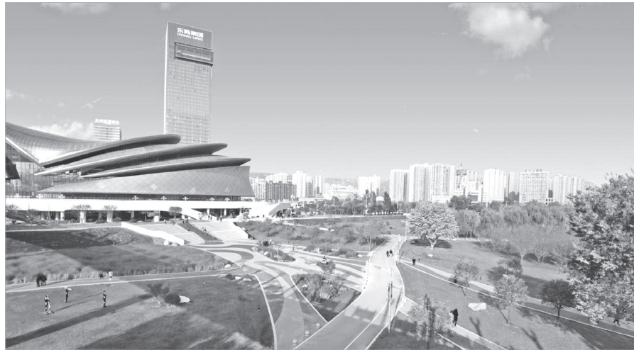
宝鸡大剧院南侧渭河公园绿化提升改造
