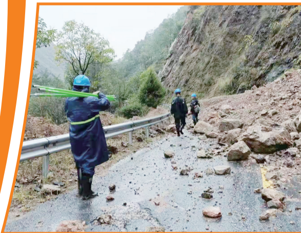
抢修移动通信线路
