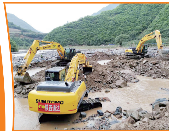
挖掘机疏通通关河道
