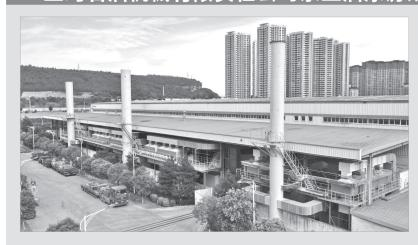
投资 873 万元 建成的宝鸡石油机 械有限责任公司泵 业油漆房改造项目, 采用组合工艺"水旋 +活性炭吸附脱附 +催化燃烧法",对 原有喷漆室、调漆间 及其相关设施项目 进行改造,新增的活 性炭吸附脱附和催 化燃烧设备将废气 排放量大大降低,减 排效果显著。
