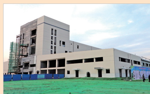
项目主体已封顶
