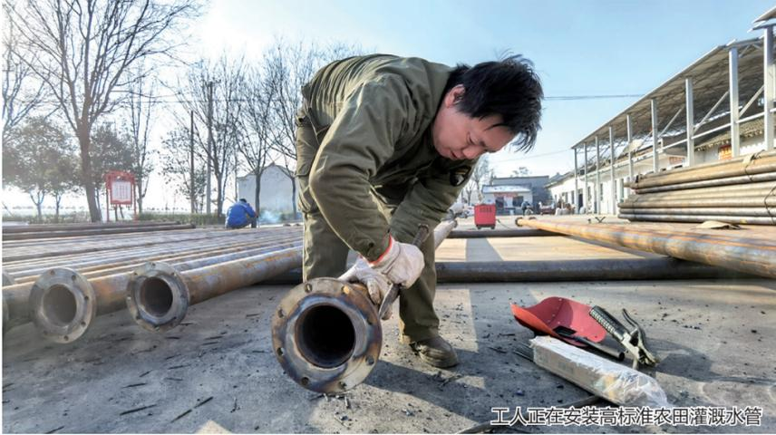
工人正在安装高标准农田灌溉水管
