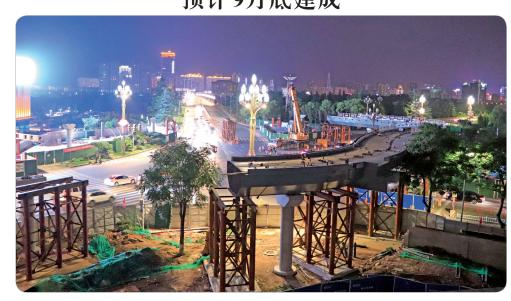
本报讯 7月13日22时许,市区宝烟路与金台大道交叉路口处的宝鸡市文化艺术中心人行天桥项目施工现场一片繁忙(见左图),施工人员正在吊装桥体部分钢箱梁。据悉,目前整体工程已完成55%,天桥预计9月底可建成。
