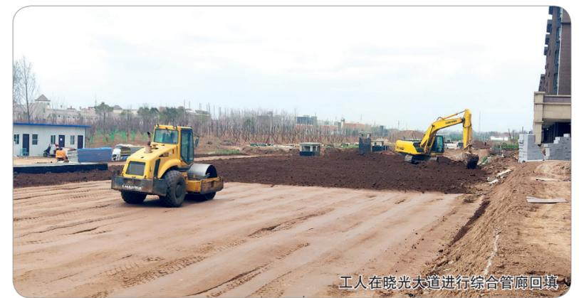
工人在晓光大道进行综合管廊回填
