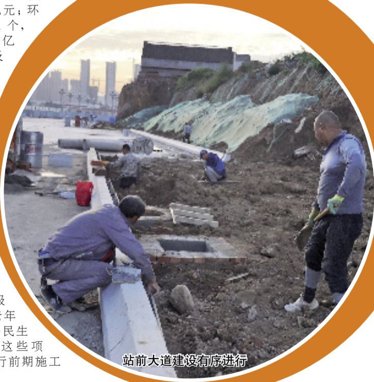
高铁电气科技产业园项目现场
