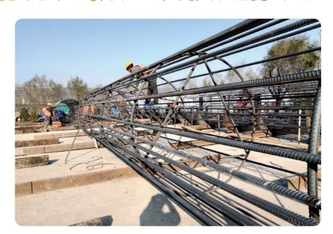
大桥施工现场,项目负责人郭利文介绍, 清溪渭河大桥南起高新二十一路,北接 水莲路,全长1577米,工期2年。施工队 自9月底进场以来,没有休息过一天。截 河堤便道,具备了南北施工条件。主河槽 钢栈桥建设完成,清溪渭河大桥北侧桩 基开始全面施工,已完成2.5米主塔墩 柱一根,引桥墩柱7根。
