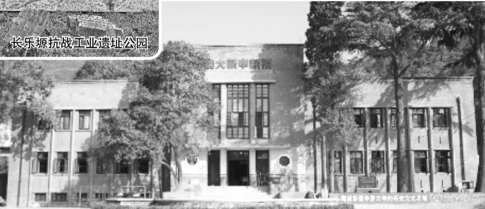
福新中新大楼
