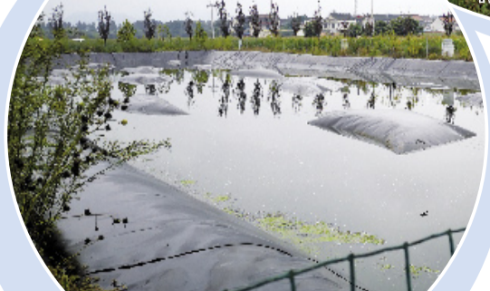
野寺村建成3个尿污处理池,对养殖产生的粪污进行无害化处理。
