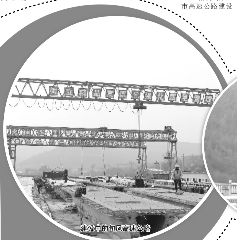
预制梁板浇筑施工现场
