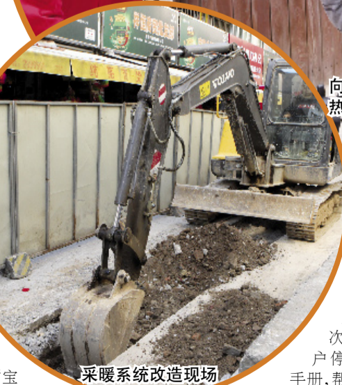
采暖系统改造现场
