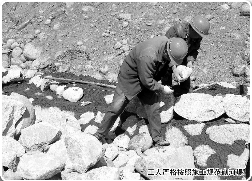
热火朝天的施工现场
