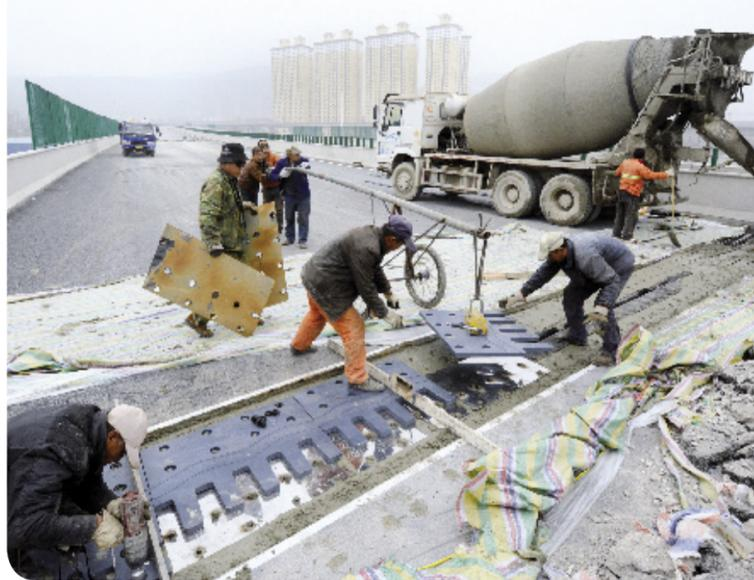
11月13日下午4时,十几名工人在宝鸡绕城高速高架桥上安装大桥伸缩缝。
