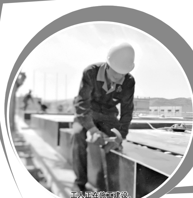
工人正在施工建设
