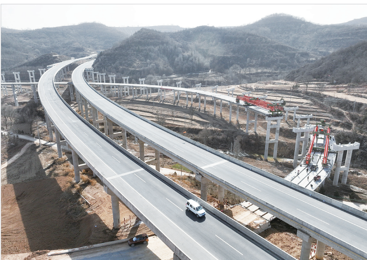
麟法高速石鼓峡立交建设现场(资料图) 本报记者 谢克强摄
