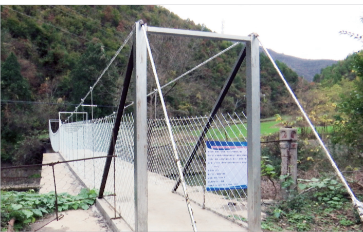
建成投用的费家庄村五组人行吊桥
