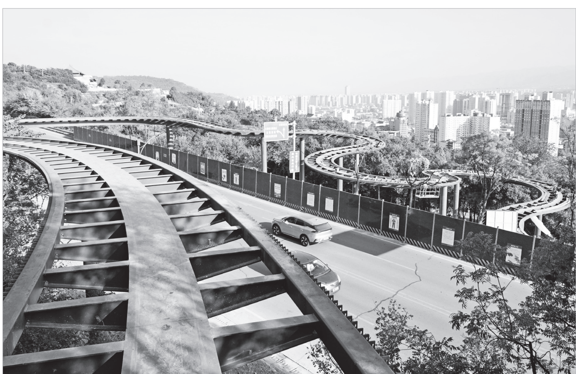
栈桥弯弯曲曲跨过上塬路
