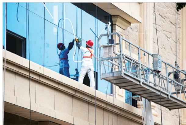
“蜘蛛侠”在高层建筑安装玻璃幕墙
