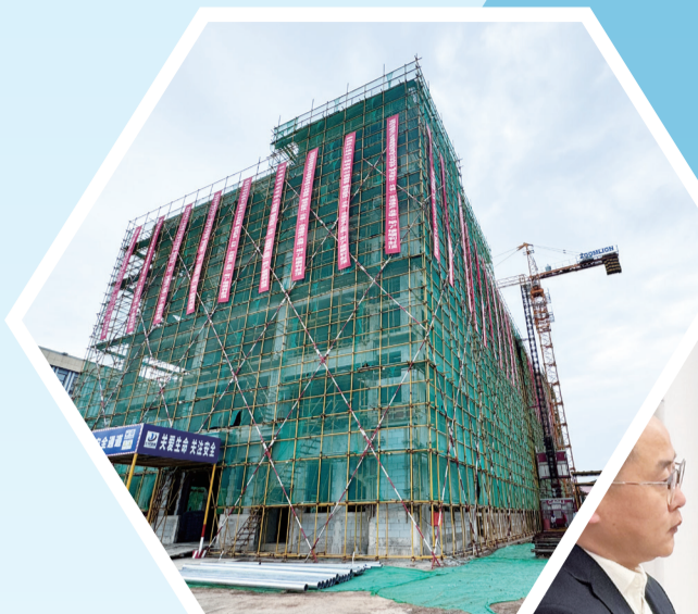
蟠龙高新区公共实训 基地项目实训楼主体封顶
