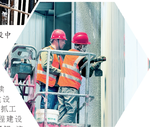
▶ 锐诚钛业新办公楼进入装修阶段
