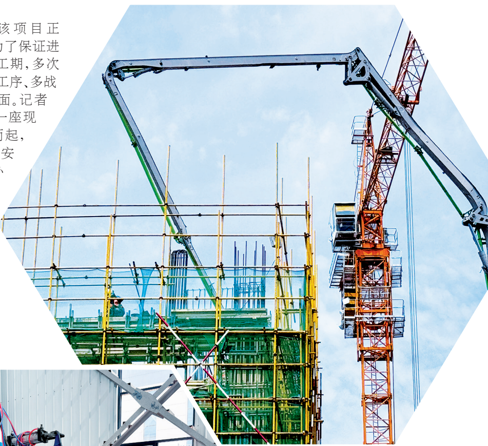
▶ 工人对实训楼进行混凝土浇筑作业
