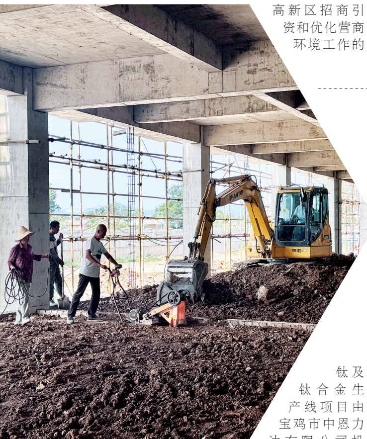
▶ 项目建设现场一片忙碌景象
