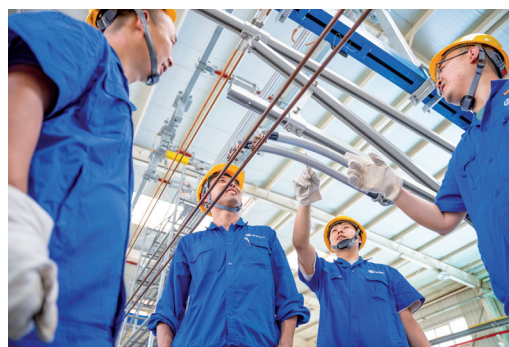
中铁高铁电气技术人员对接触网装备进行试验
