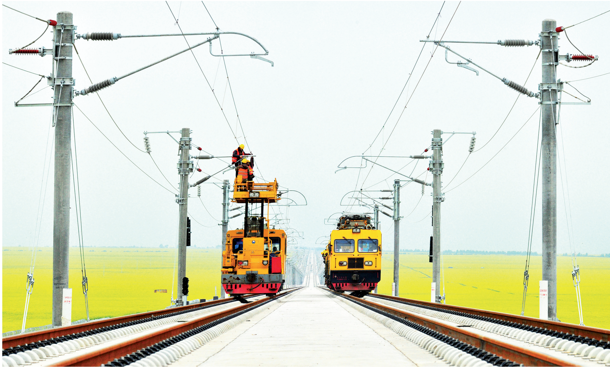
中铁高铁电气施工人员在架设接触网导线
