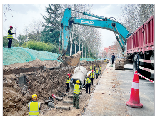
城市雨污管网改造工程施工现场
