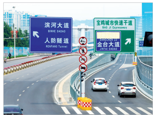
宝鸡城市快速干道新开通的高新立交入口
