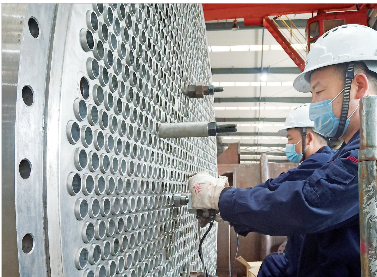
工人在安装钛产品
