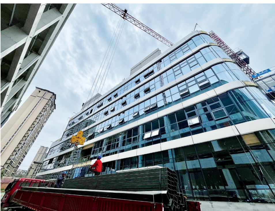
施工人员正在装修厂房
