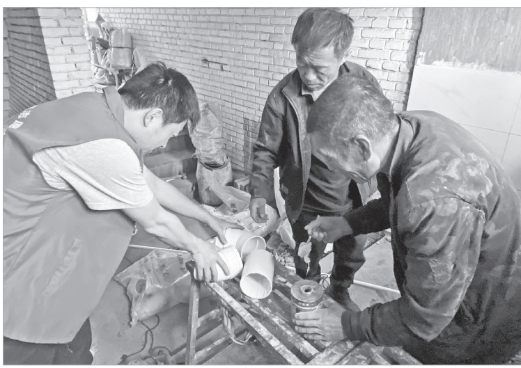
工人和志愿者在加紧施工
