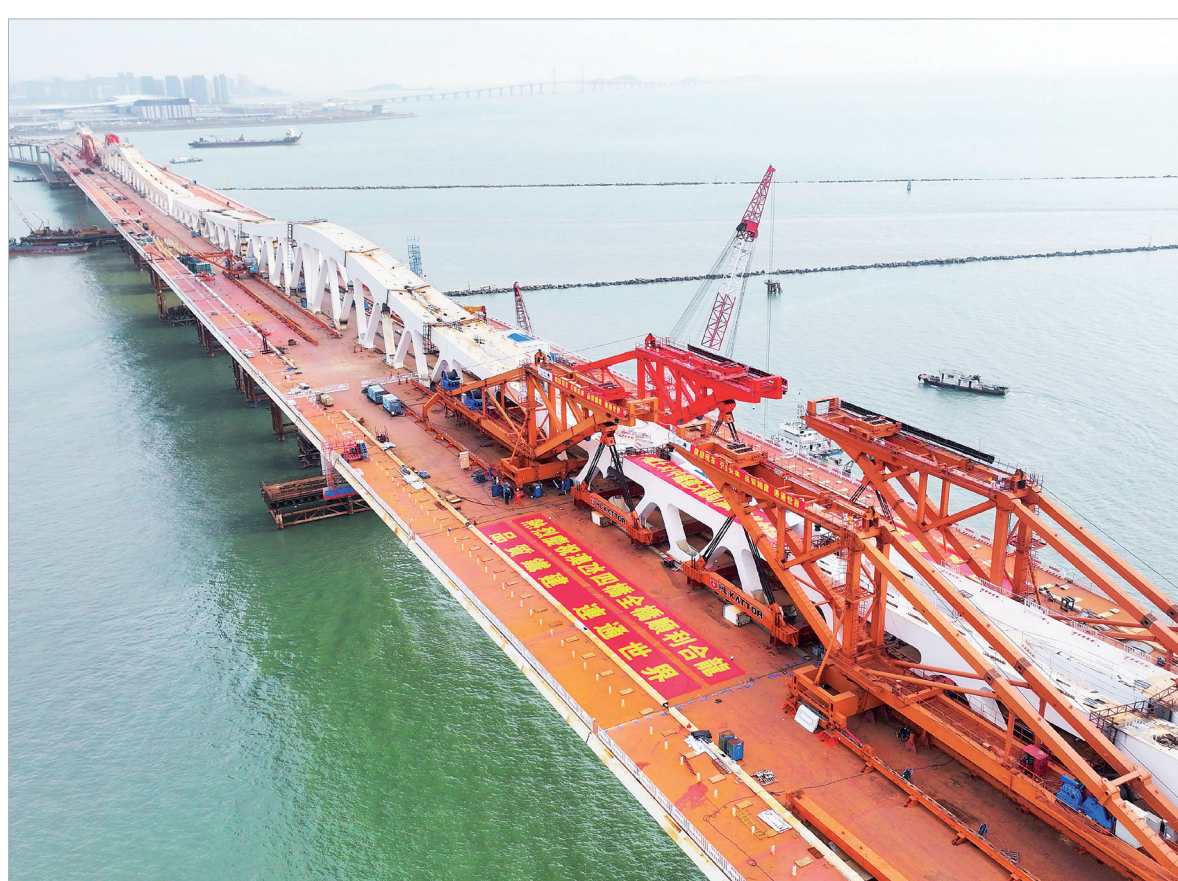
大桥合龙现场（中铁宝桥供图）
