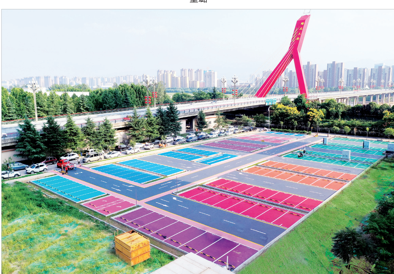
2023年9月，蟠龙大桥西生态停车场竣工。（资料图）
